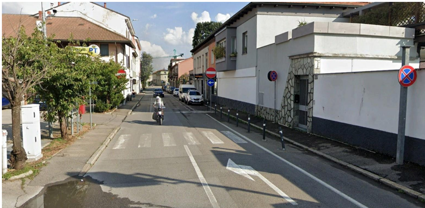
Figura 12: Assenza di rampa di raccordo tra il marciapiede e la sede stradale in via Napoleone Bonaparte
