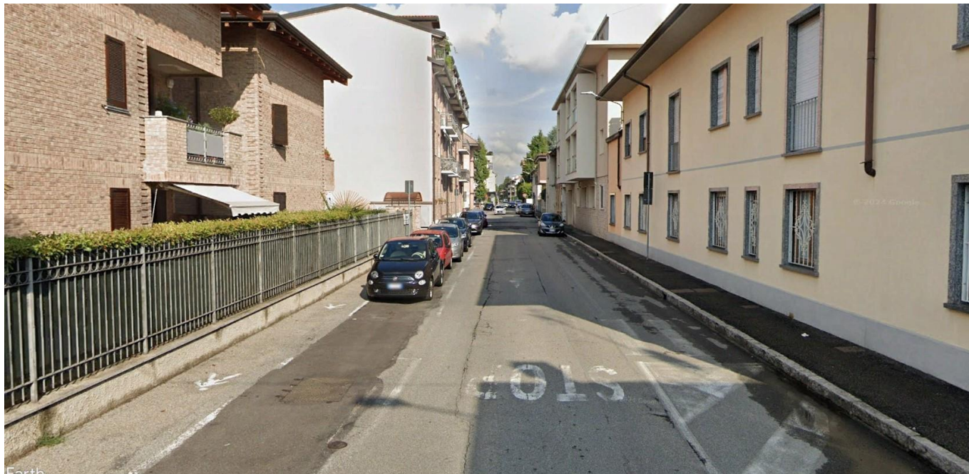
Figura 2: Vicinanza degli stalli di sosta all'attraversamento pedonale e segnaletica orizzontale usurata in Via Alfieri in corrispondenza di via Manzoni
