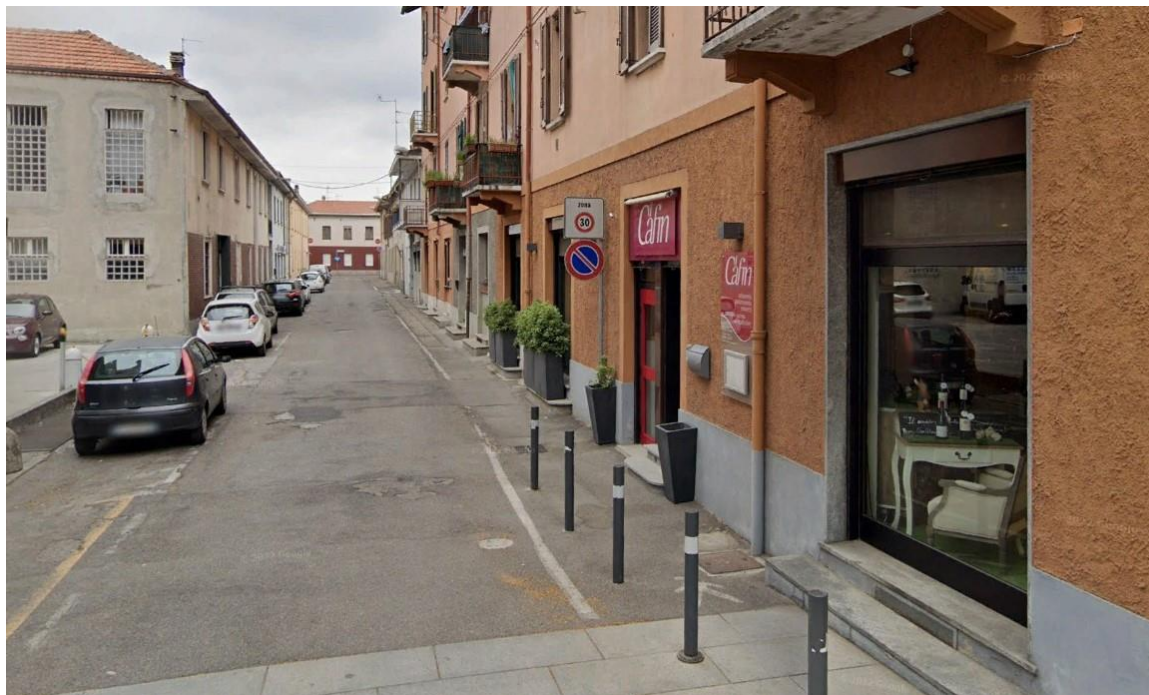
Figura 43: Assenza di segnaletica orizzontale di Zona 30 in via XX Settembre
