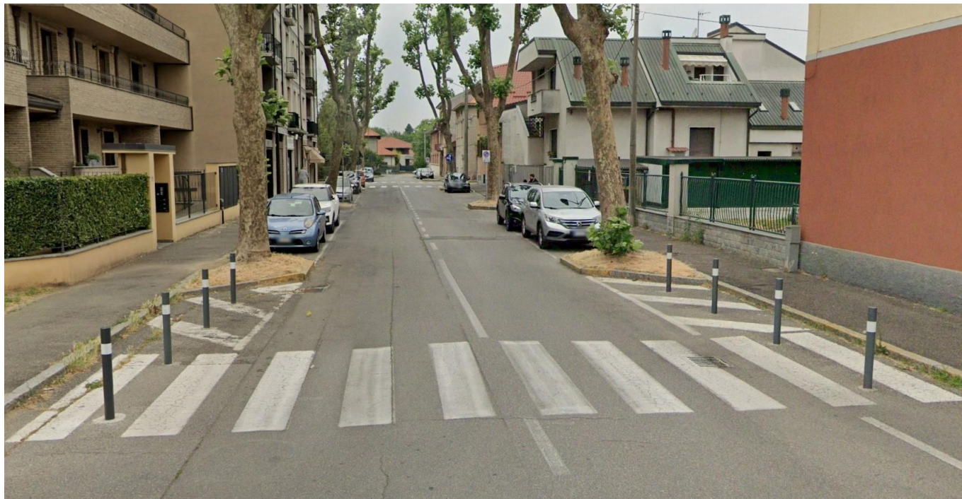
Figura 11: Assenza di rampa di raccordo tra il marciapiede e la sede stradale in via Tonale in corrispondenza di via Tolmino
