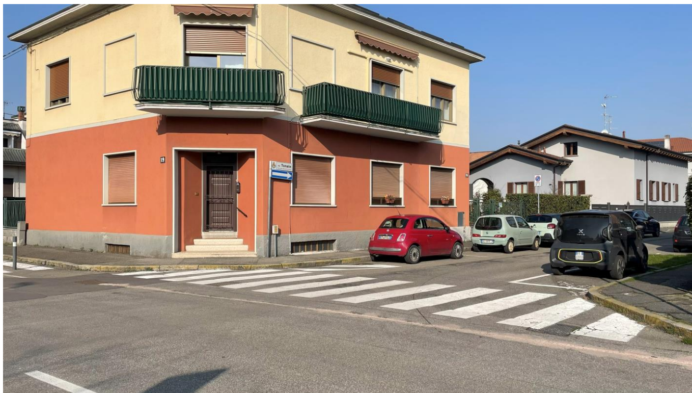
Figura 11: Assenza di rampa di raccordo tra il marciapiede e la sede stradale in via Tonale in corrispondenza di via Tolmino
