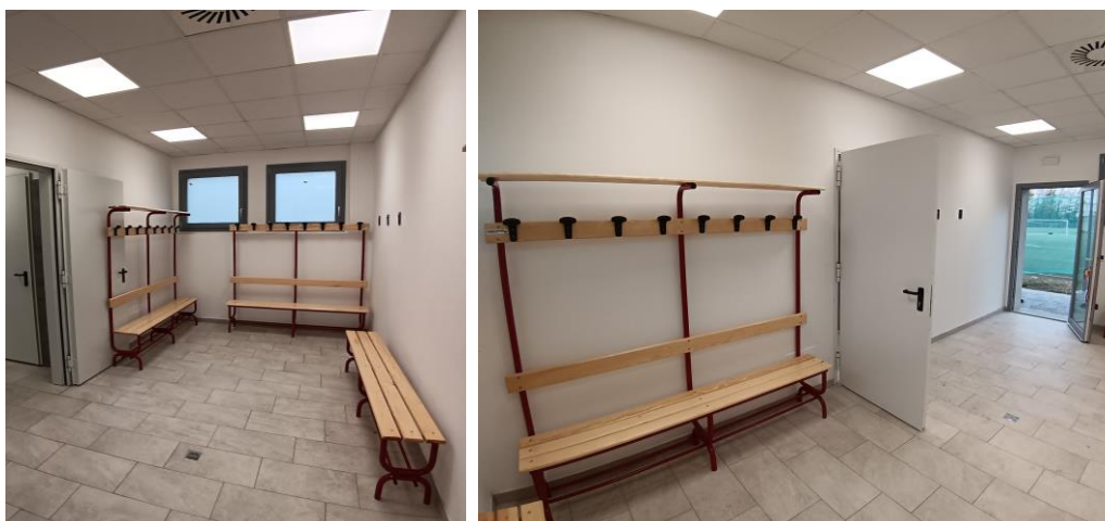
(Foto Edificio A.2 -spogliatoi)
